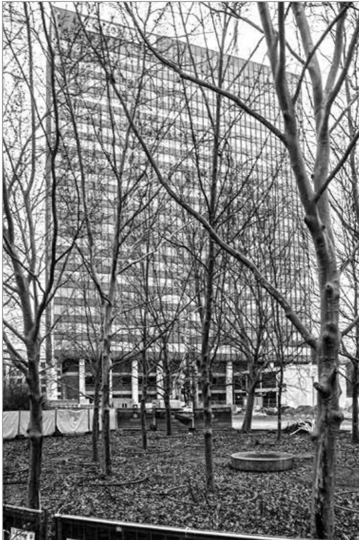
Foto: WGK / Umbau auf dem Areal der ehem. Postbank
