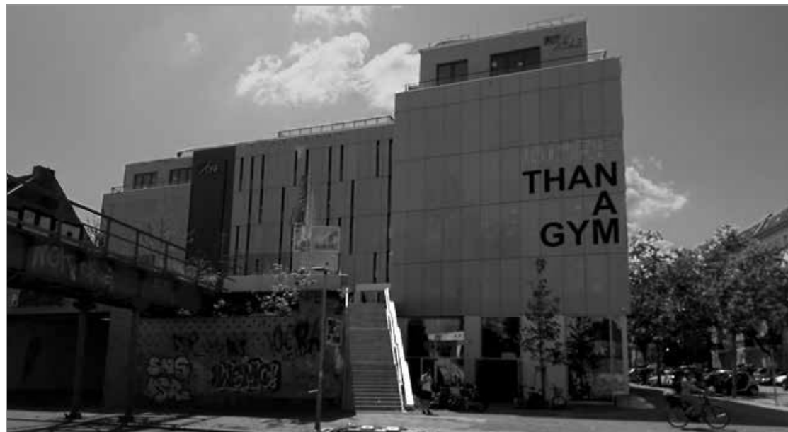
Foto unten: Berliner Bauleiter vom 3.08.2019 Yorckstraße/Ecke Bautzener
